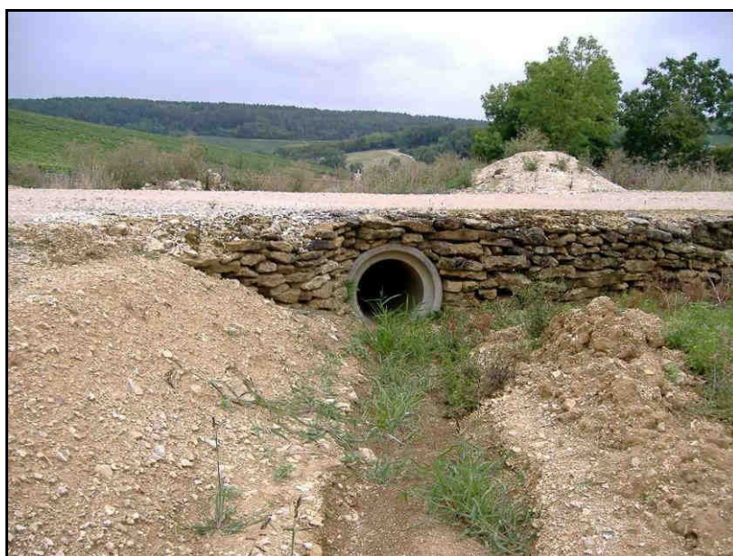
Photo 3 : exutoire de type fossé busé, à Beine
